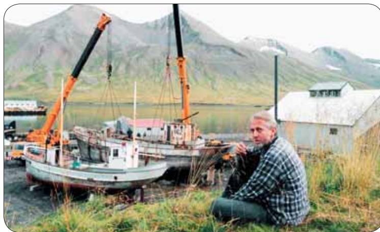
Skipunum komið fyrir í grunni væntanlegs bátahúss – Örlygur slappar af eftir langa vinnutörn.
