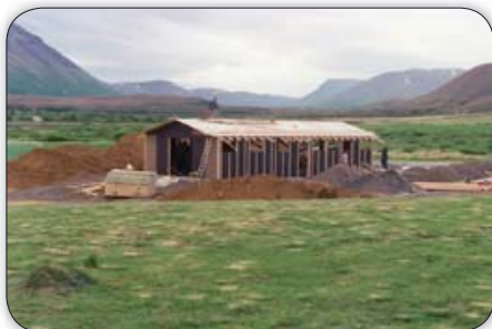
Sundlaugarhús í byggingu.
