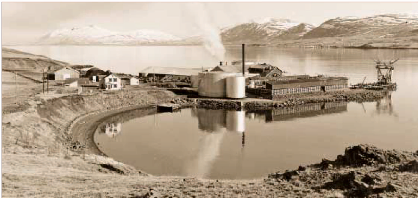
Síldarverksmiðjan í Krossanesi - en í kringum hana myndaðist Glerárþorp. Norðmaðurinn Holdö rak verksmiðjuna um langt skeið og átti hann í mikilli kjara-baráttu við Akureyringa árið 1930.
